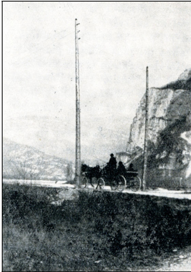
Tournée d'inspection de la ligne
